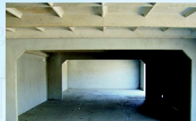
Sestava modulů B6 spojených otevřenou vnitřní stěnou - vnitřní pohled
