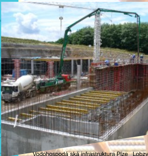
Vodohospodá ská infrastruktura Plze - Lobzy
