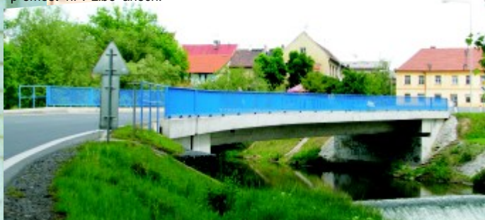
Dodávka transportbetonu a výztuže na stavbu p emost ní v Libo anech.
