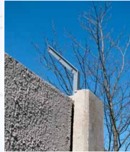
Zhlaví sloupku (typ C) s ocelovým profilem pro ostnatý drát.
