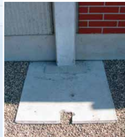
Uložení sloupku do prefabrikovaného deskového základu ZP 7.
