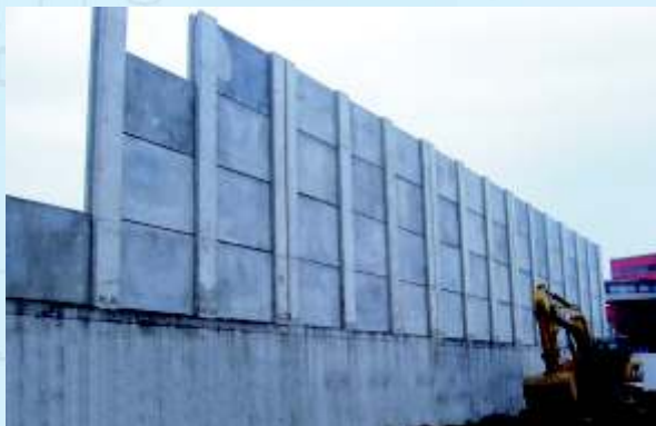
Protiprašné stěnové dílce vkládané do nosných sloupů tvaru H.
