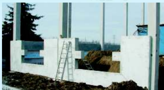
Základové prahy upravené pro vybudování nakládačích můstků.
