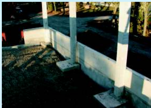
Základové prahy uložené na patkách a před líc nosné konstrukce.
